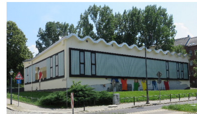
Turnhalle Grundschule Sonnenberg
