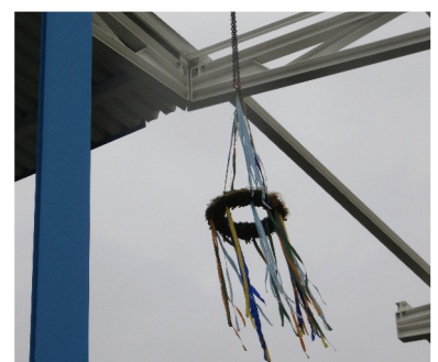
Richtfest im Stadion Gellertstraße
