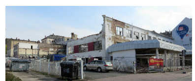
Ehemalige Fabrik Leistner
